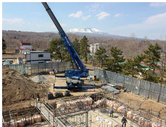
令和8年4月 情報エレクトロニクス棟建設の進捗状況
