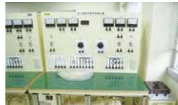
▲直流電動発電機実験設備
