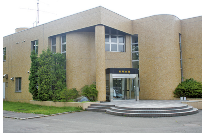
▲福利施設（鵬翔会館）
